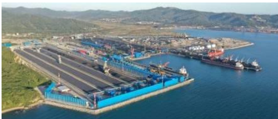
Рисунок 4-12. Ветрозащитные экраны на ППК-3 (установлены с южной и восточной сторон периметра ППК-3 и причала 49 на ППК-3 (2-я очередь), с западной, южной, восточной и северной стороны периметра Т-3 (3-я очередь)
