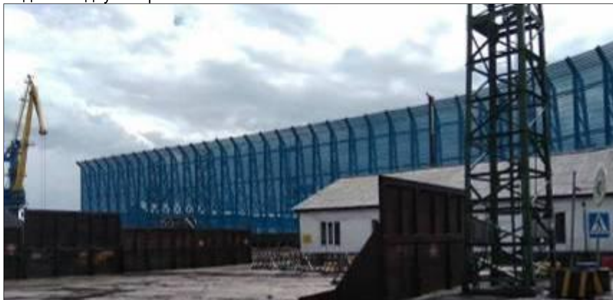
Рисунок 4-11. Вид ветрозащитного экрана на причале №11
