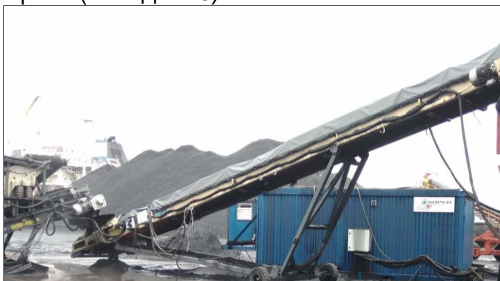
Рисунок 4-5. Крытые галереи конвейерной ленты ДСК
