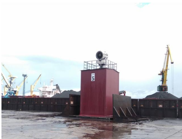
Рисунок 4-1. Стационарная оросительная установка
